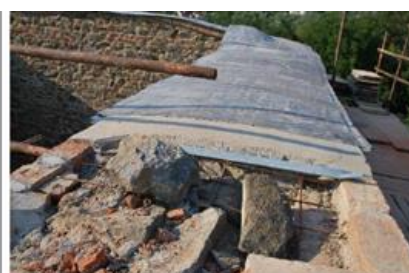
Ukázka krytí koruny zdiva olověným plechem s přesahem přes líc zdi
