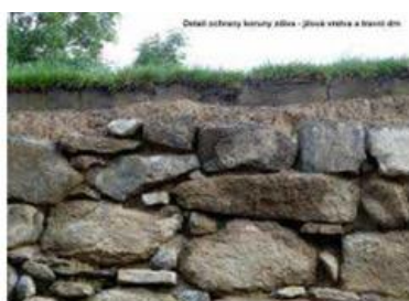
Ukázka krytí koruny zdiva travním drnem
