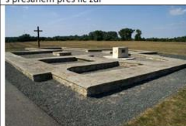
Ukázka krytí koruny zdiva kamennými deskami
